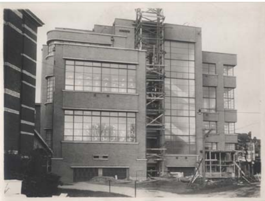
Institut de stomatologie, façade est en construction, photographie non datée.
